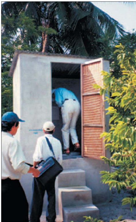
Figure 17. Une toilette à séparation d'urine et surélevée au Vietnam
