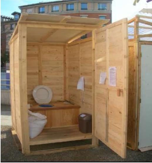
Figure 12: TLB en bois, démontable. Photographie : La case de l'Anethon
